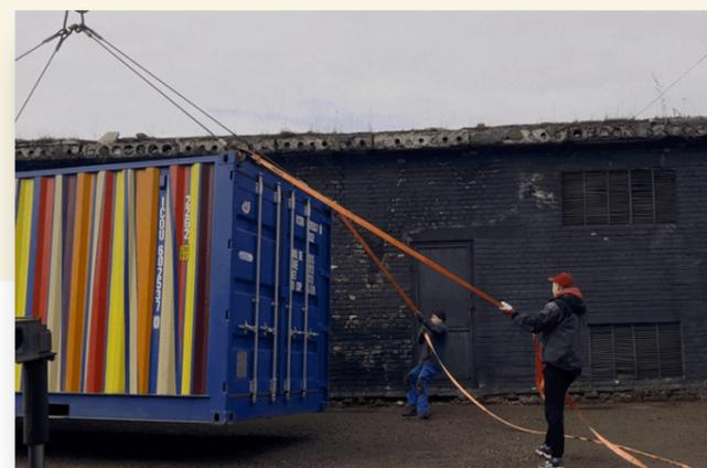
Für den Aufbau werden kein Erdaushub und keine für die Ewigkeit gegossenen Betonfundamente benötigt. Das spart Geld und Zeit.
