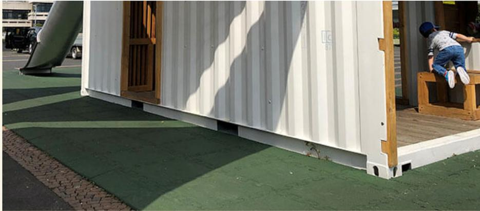
Die Container bestehen aus widerstandsfähigen COR-TEN-Stahl. Die Wände werden aus Trapez-Stahlblech gefertigt.
